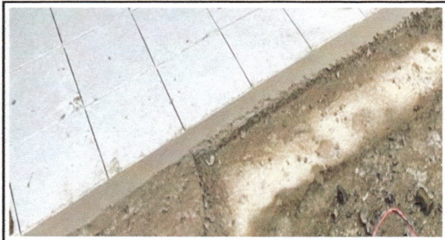
Foto 4: Se observa el avance de trabajo de reparación de piso de torta de concreto.
