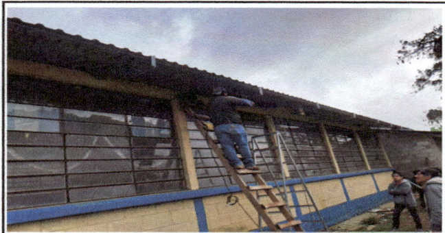
Foto 6: Se observa el avance trabajo en la sustitución de soporte o pescante de metal para canal de aguas fluviales.
