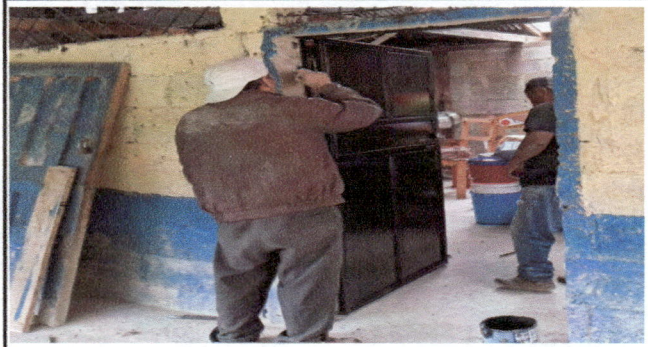
Foto 2: Se observa la sustitución de puerta de madera a puerta de metal, con la aplicación de pintura.
