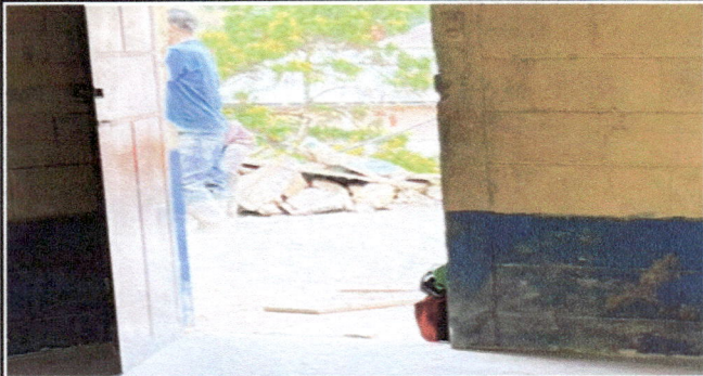
Foto 1: Se observa el trabajo de la sustitución de chapa en esta puerta.
