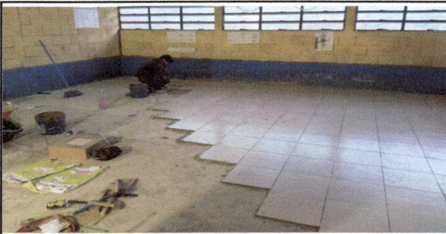
Foto 5: Se observa el avance de trabajo en la sustitución torta de concreto a piso cerámico.
