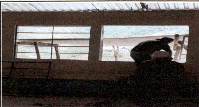
Foto 3: Se observa la sustitución de ventanas de madera por venta de metal más vidrio.
